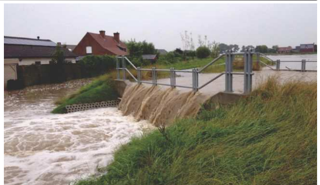
Foto helemaal boven : overstroming in Roeselare op 31 mei 2016. Foto hierboven : 31 mei 2016 : water treedt uit voegen in Pittem.
