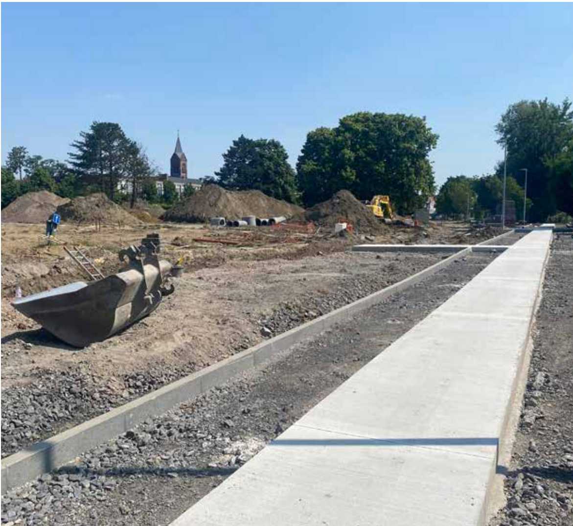
Ontharding van een centrumstraat in Wevelgem.
